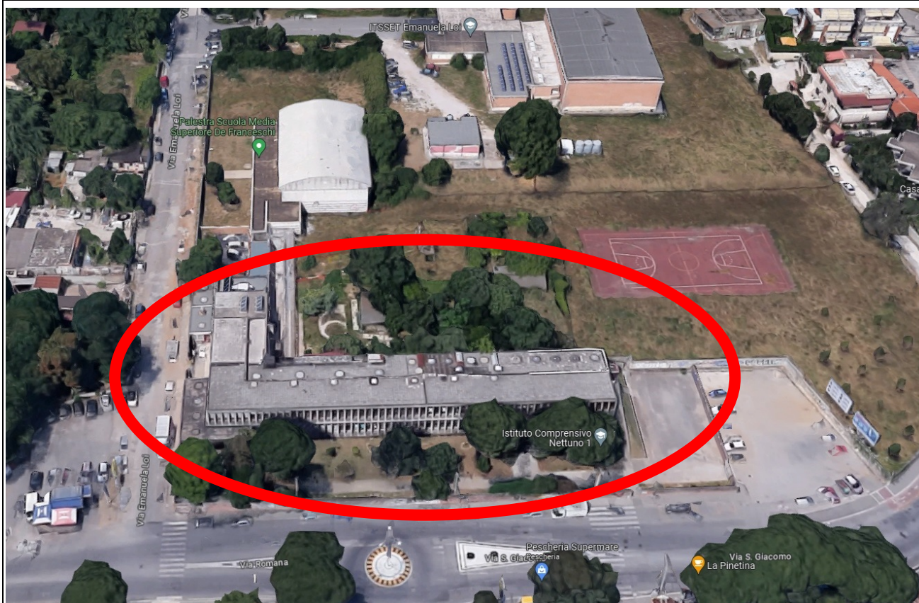
Vista area edificio da demolire
