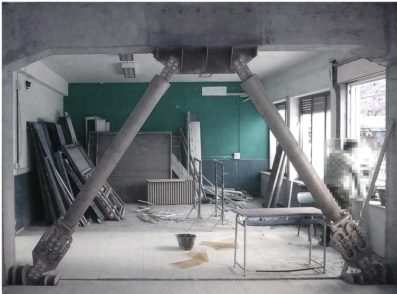
Installazione di controventi dissipativi
